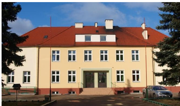
Obecny wygląd budynku szkoły od frontu.
