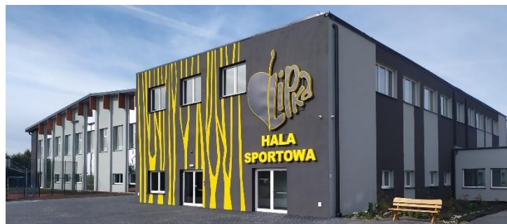
Hala sportowo – widowiskowa otwarta w 2023 roku.
